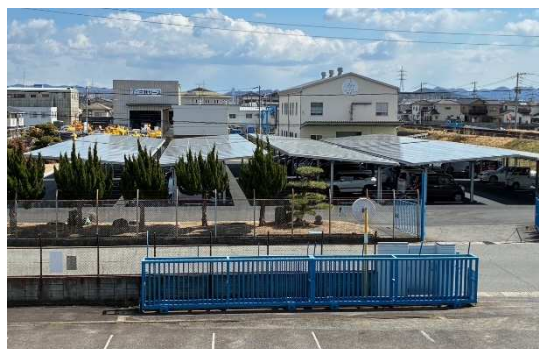
駐車場カーポート上
